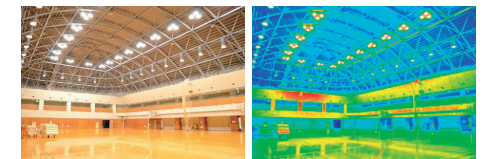
施工後(LED)762Lux
